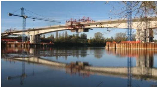
Viadotto sull'Adige (VR) Lombardi-Reico srl
